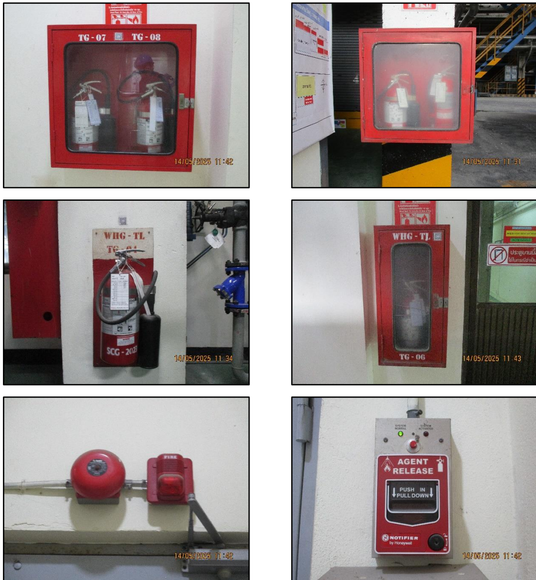
ภาพที่ 2.12 อุปกรณ์ป้องกันและระงับอัคคีภัยประจำบริเวณต่างๆ ภายในโรงงาน
